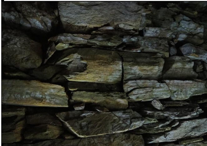
玄室内部壁 小口積みされた緑泥片岩
